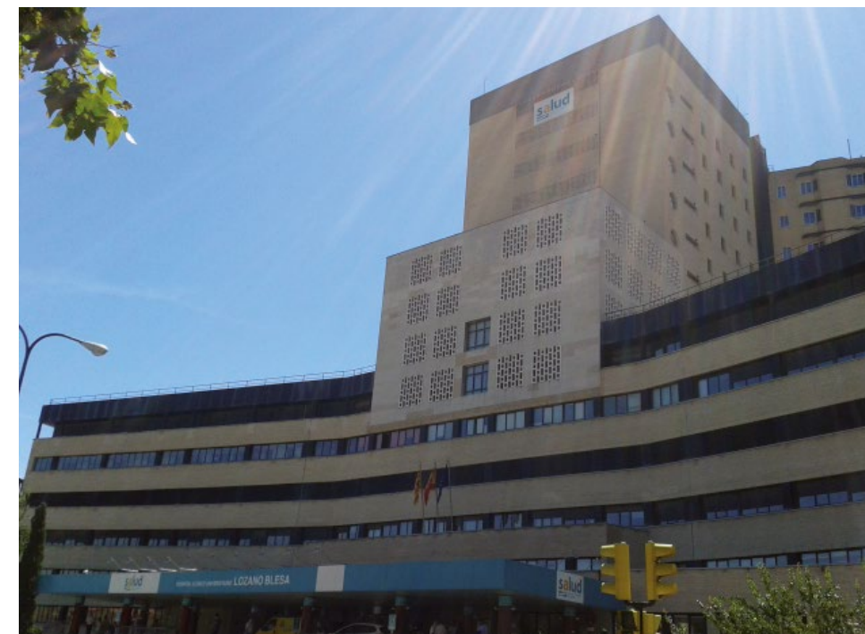
Vista exterior del Hospital Clínico Universitario Lozano Blesa de Zaragoza
