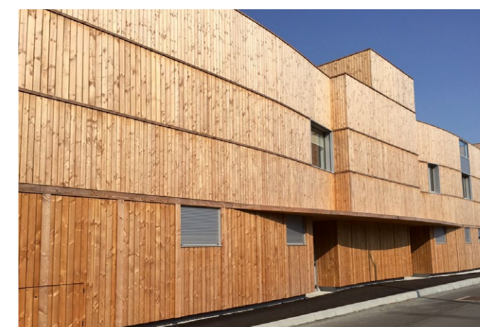
Vista exterior del Centro Hospitalario de Niort
